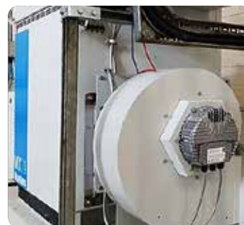
Po upgradu Stejná jednotka nyní vybavená novým EC motorem ventilátoru.
