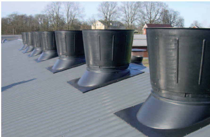
Euroemme® TU-ventilatorer installeres gennem taget på en bygning.
