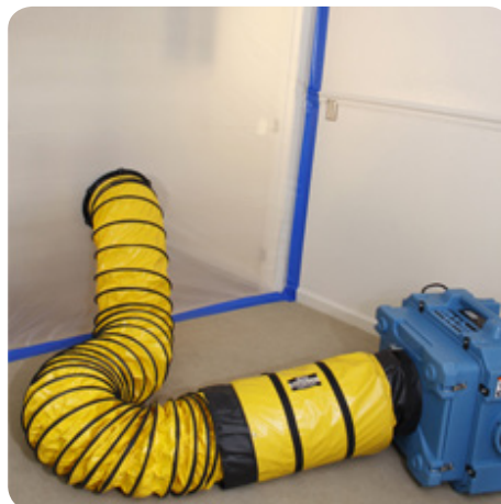
HEPA500 placeret udenfor det behandlede område og monteret med Ø305 mm Sto&Go-slange.
