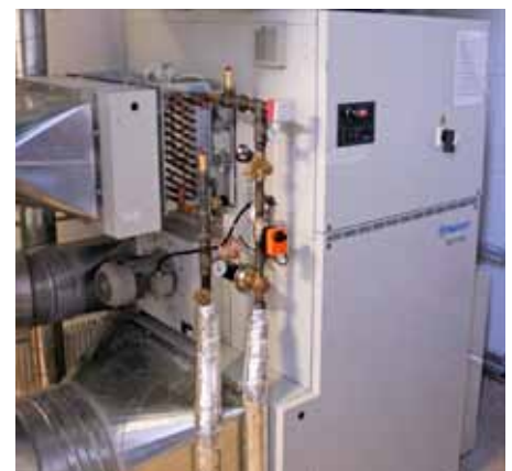
MXT7500 jetzt ausgerüstet mit Vorerhitzer und internem Wärmerückgewinnungssektor, dem EnergyRecoveryPurge
