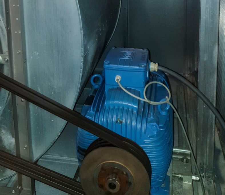
Prima: ventilatori con trasmissione a cinghia
