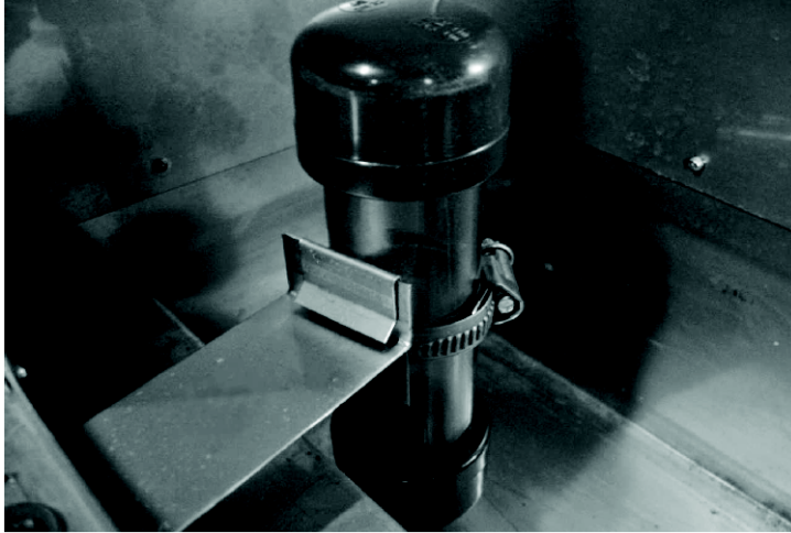
Abb 4.6 Chlorid-Tablettendosierungssystem
