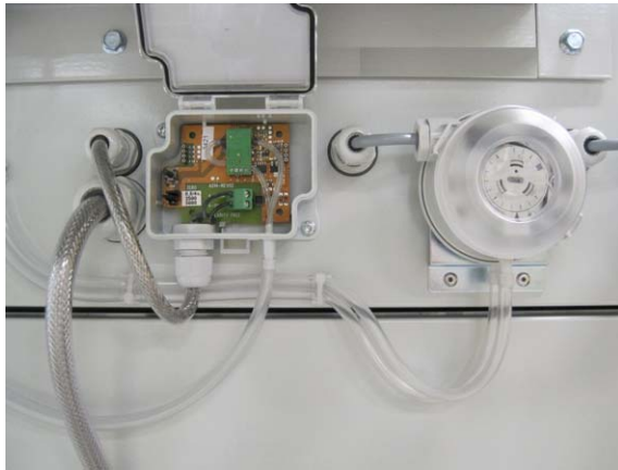
Figur 3.22 Anslutning för DPT (regenereringsfläkt)
