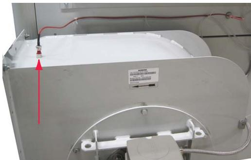
Abb 3.21 PT1000-Anschluss am Regenerationsventilator
