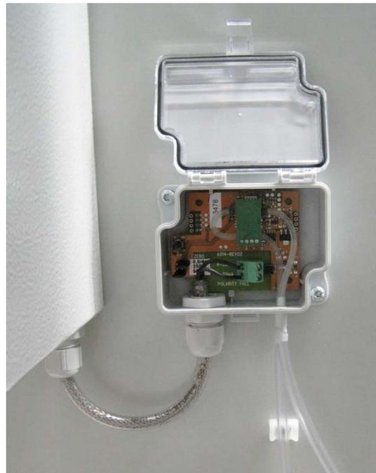
*Abb 3.23 Anschluss für Differenzdruck-Messumformer (Prozessventilator)*
