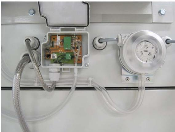
*Abb 3.22 Anschluss für Differenzdruck-Messumformer (Regenerationsventilator)*
