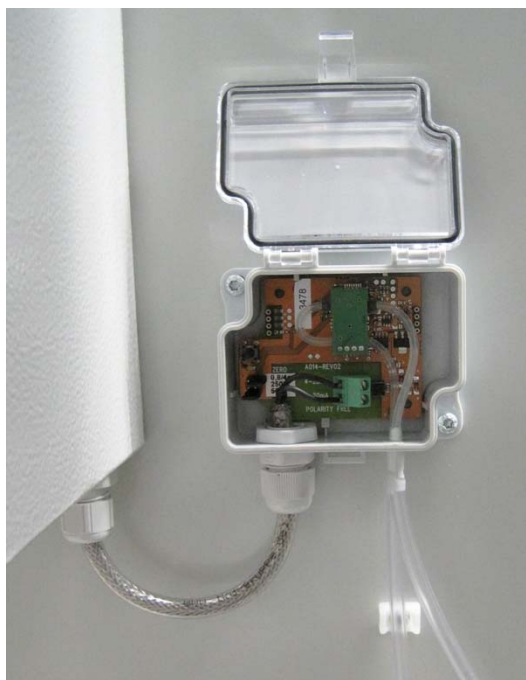
Figur 3.23 Tilslutning for DPT (procesventilator)
