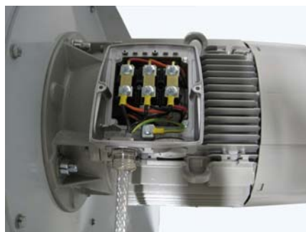
Figur 3.15 Kabelføring for ventilatormotor
