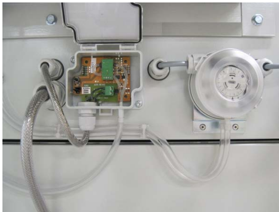
Figur 3.22 Tilslutning for DPT (regenereringsventilator)
