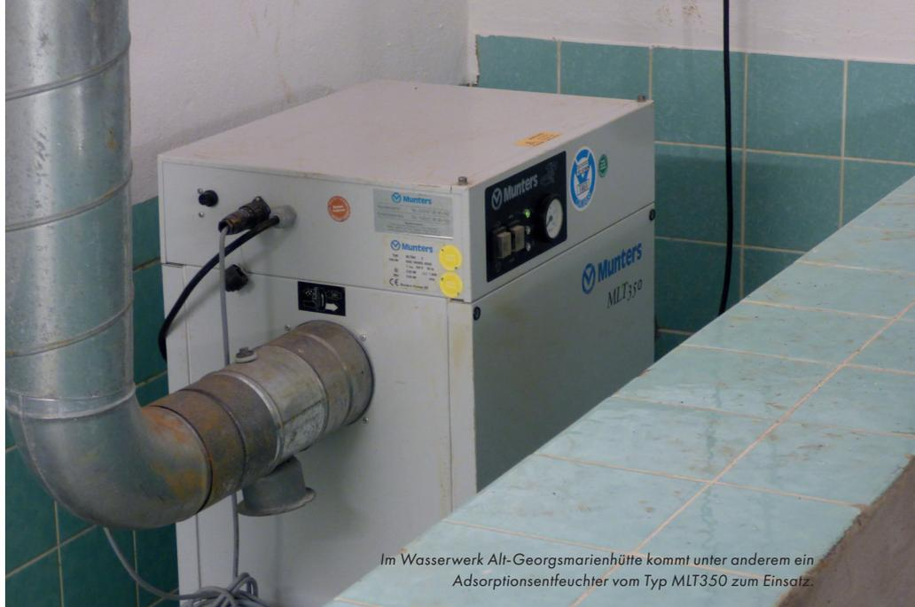
Im Wasserwerk Alt-Georgsmarienhütte kommt unter anderem ein Adsorptionsentfeuchter vom Typ MLT350 zum Einsatz.
