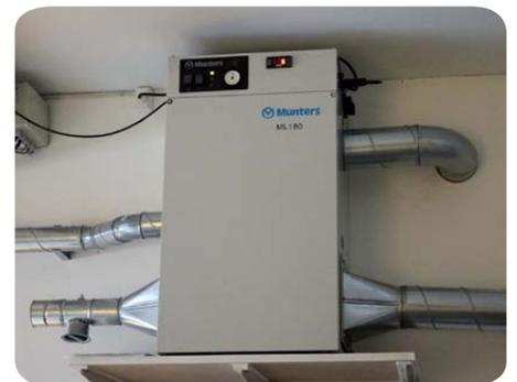
Der Sorptionsentfeuchter vom Typ ML180 wurde außerhalb des Trockenlagers platziert.
