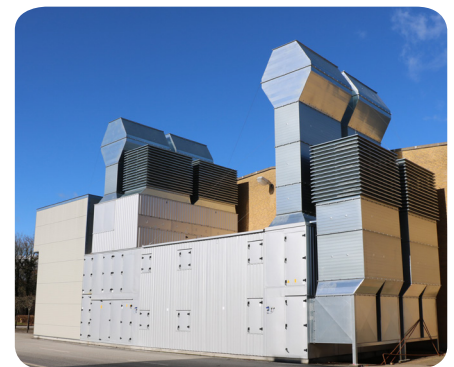
Ét af de to største anlæg på hver 126.000m 3 /h har erstattet 6 mindre anlæg og sikret store besparelser.
