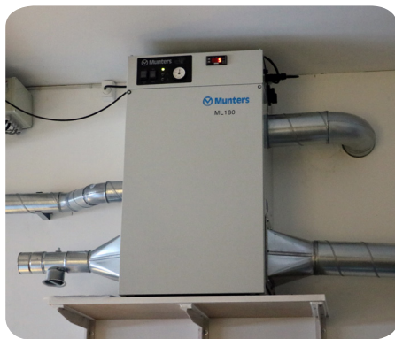
Sorptionsaffugter type ML180 placeret umiddelbart udenfor tørlageret.
