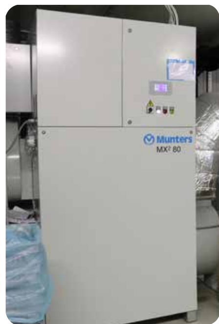
Affugter MX 2 80 udstyret med for- og efterkøleflade.
