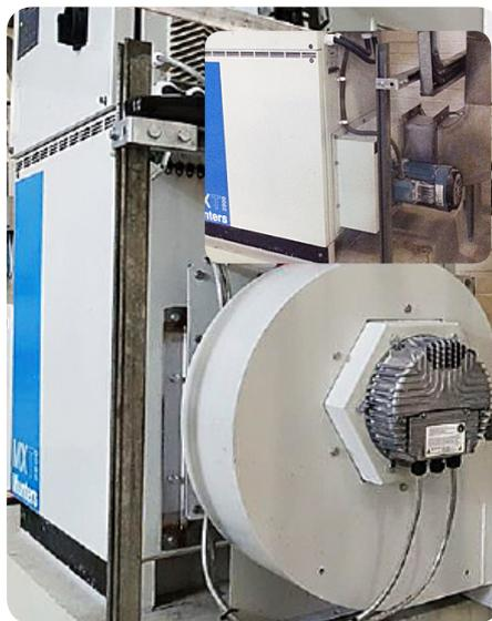
MXT2800 di Munters con il nuovo motore del ventilatore CE
