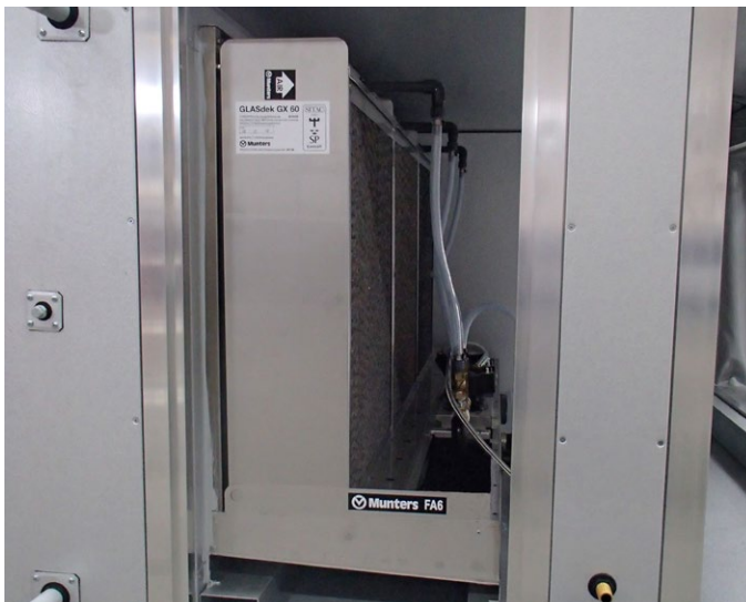
Exempel på en FA6-installation i en del av en luftbehandlingsenhet
