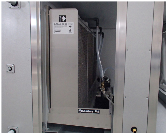
Esimerkki FA6-asennuksesta ilmapuhdistusyksikön osassa
