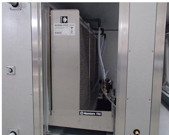
Esempio di installazione FA6 in una sezione di una unità di trattamento aria
