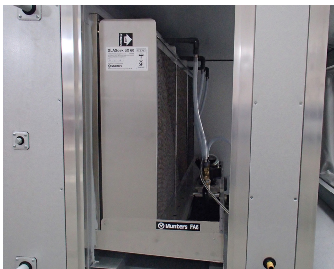
Eksempel på en FA6-installasjon i en seksjon av et luftbehandlingsaggregat.
