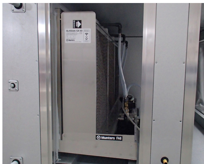
Ejemplo de una instalación de FA6 en una sección de una unidad de tratamiento de aire
