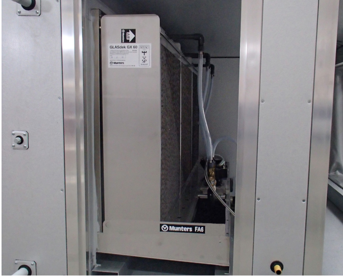
Bir klima santralinde FA6 kurulumuna örnek
