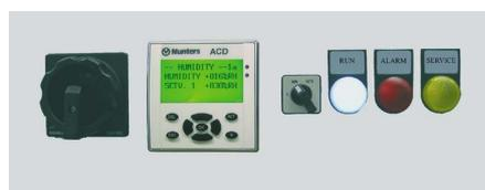
Die zwischen 2005 und 2015 verbaute ACD/ICD-Steuerung der Luftentfeuchter ML17, ML23 und MLT30 ist veraltet und entspricht nicht mehr dem Stand der heutigen Technik.
