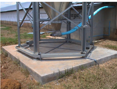
图2: 已安装好料塔的实例
