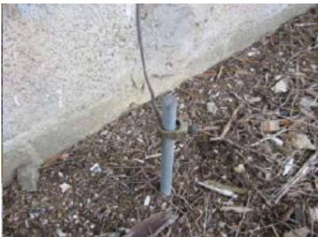
图11: 接地连接
