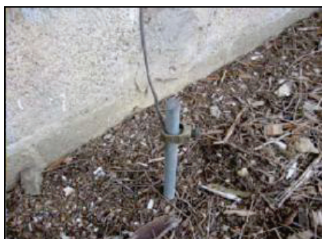
Figura 13: Conexión de Toma de Tierra
