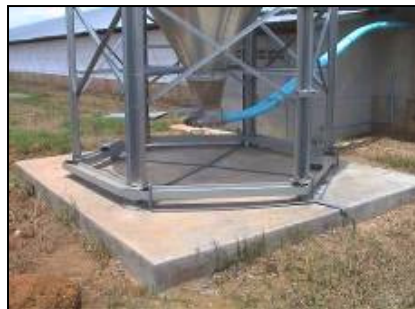
图 5: 已安装好料塔的实例
